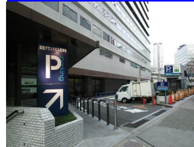
阪急グランドビル駐車場
